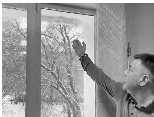
Судья показывает следы пожара
